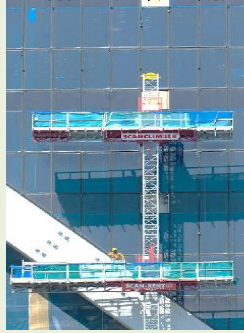
高層階の建設～改修
