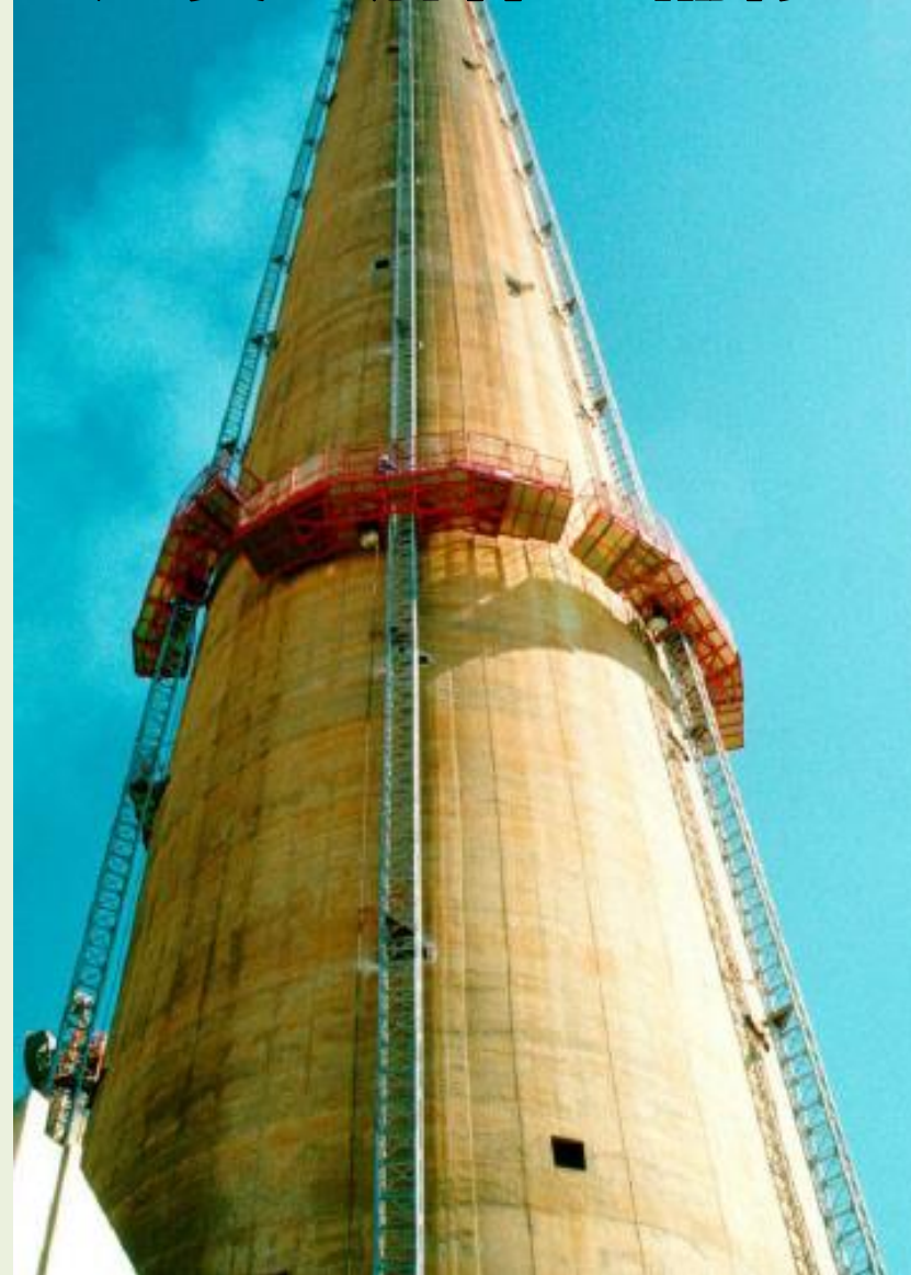
煙突の解体～補修
