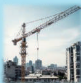
タワークレーン上部
