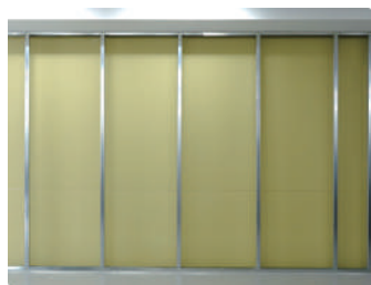
①LGSで下地を設置する
