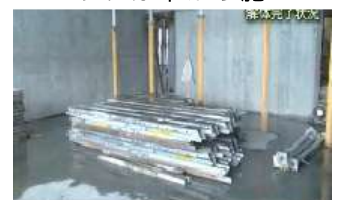
解体ゴミが極端に少ない
