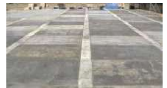
パネル表面は不陸がない
