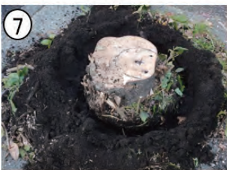
⑦ 切株と根の切削完了
