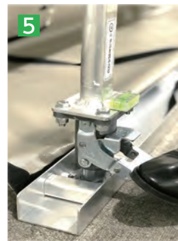
5 つっぱり棒が垂直に立っていることを確認しペダルロックを踏み込む
