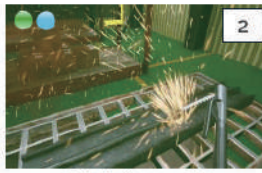
2 溶接作業での火災
