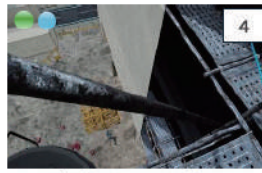
4 高所からの工具落下
