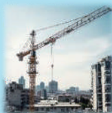
タワークレーン上部
