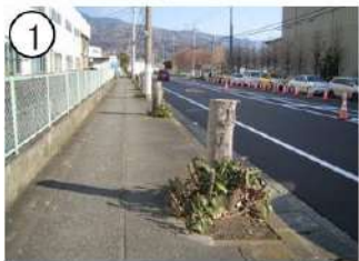
施工前の街路樹
