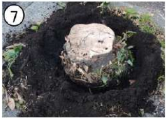
切株と根の切削完了
