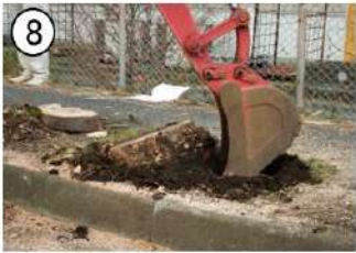
切株の掘起し
