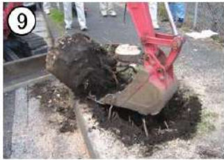
切株撤去抜根完了
