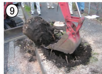
⑨ 切株撤去抜根完了
