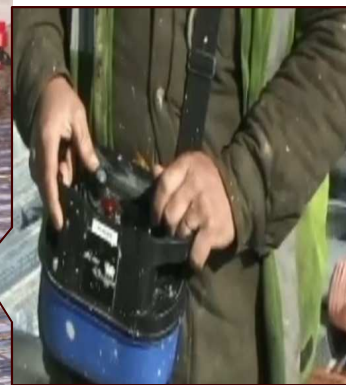
コンクリート打設時のホース取り回しをリモコン操作
