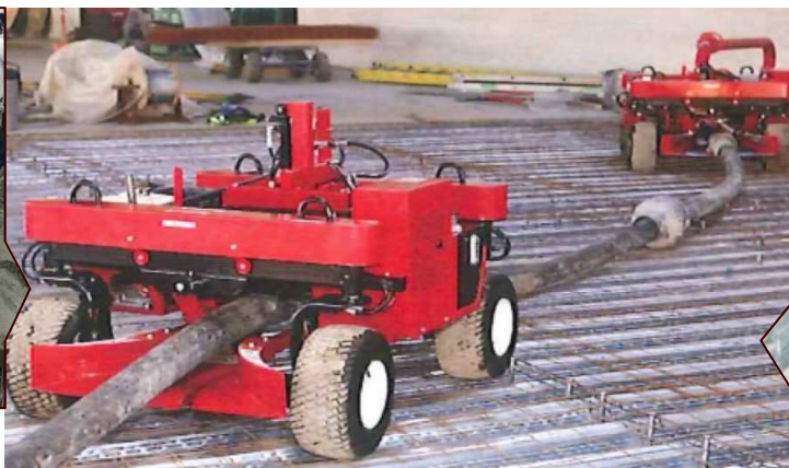
コンクリート打設時のホース取り回しをリモコン操作
