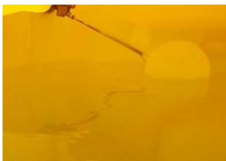
タンク内部写真(ボールタップ)
