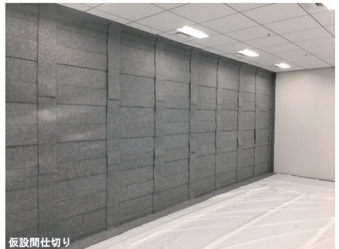
仮設間仕切り
