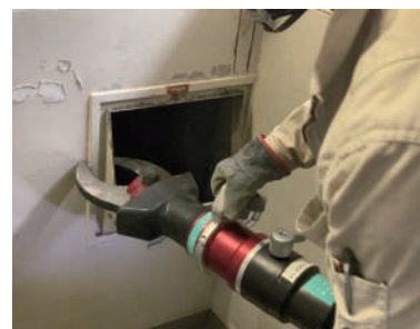
SD枠 解体風景
