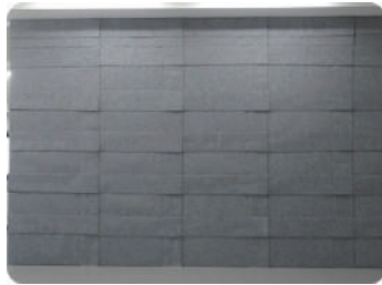
⑤施工完了
