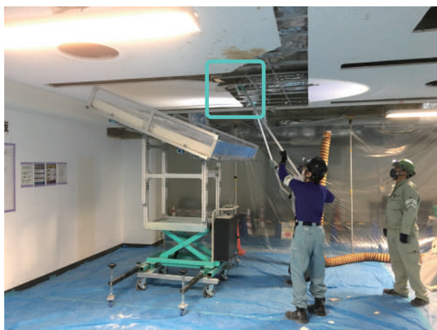
作業風景 ボードスライダーとセットで使うことで静かに解体が可能
