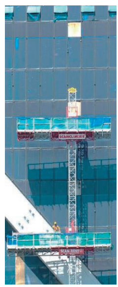
高層建築の新設・改修
