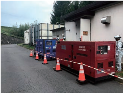
上信越自動車道 東部湯の丸サービスエリア
