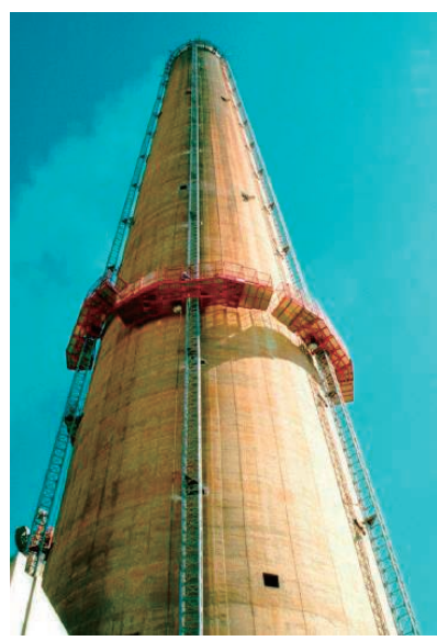
煙突の補修・解体
