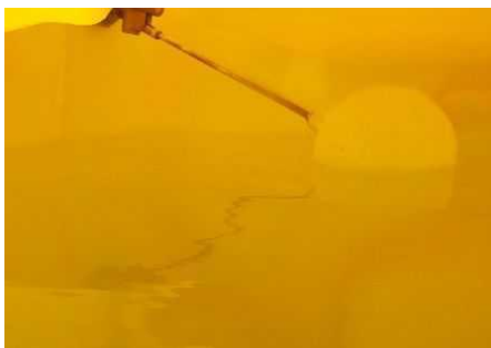
タンク内部写真(ボールタップ)
