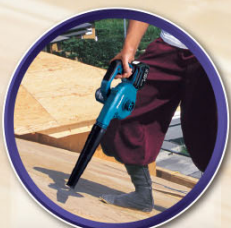
屋根工事の掃除に
