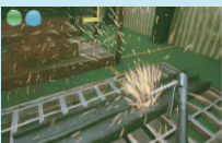
溶接作業での火災
