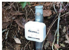
傾斜・法面の 傾斜監視
