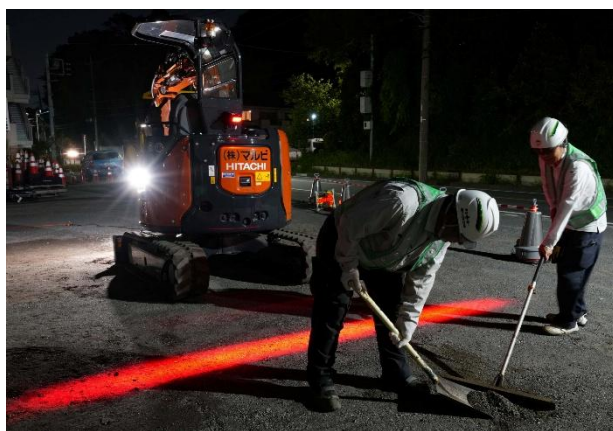
【マルビームを用いた作業風景】
