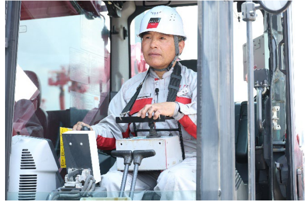
クレーン操作と治具の操作を同調させながら操作を行う(抜き取り・巻き取り共に)
