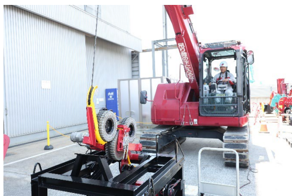
【「クレーンワイヤー交換治具」使用時全景】
