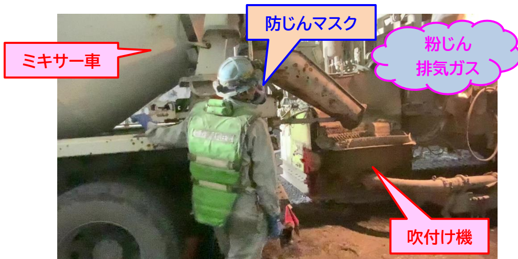
写真 1 従来のトンネル吹付け時におけるミキサー車操作状況例
