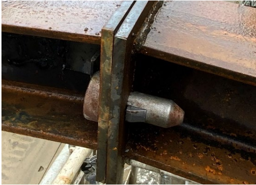
【写真 3】ワンタッチ式継手ボルト
