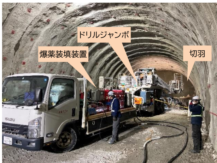
写真5 装薬時の機械配置
