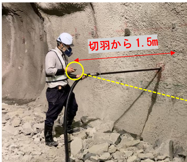
写真1 装薬作業状況
