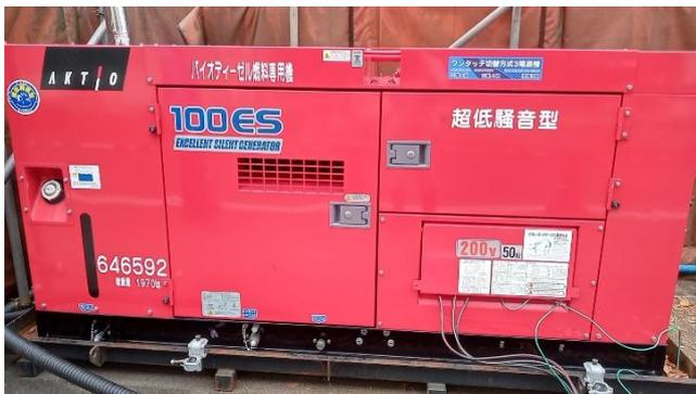
【発電容量80kVAでのB100燃料使用開始】
