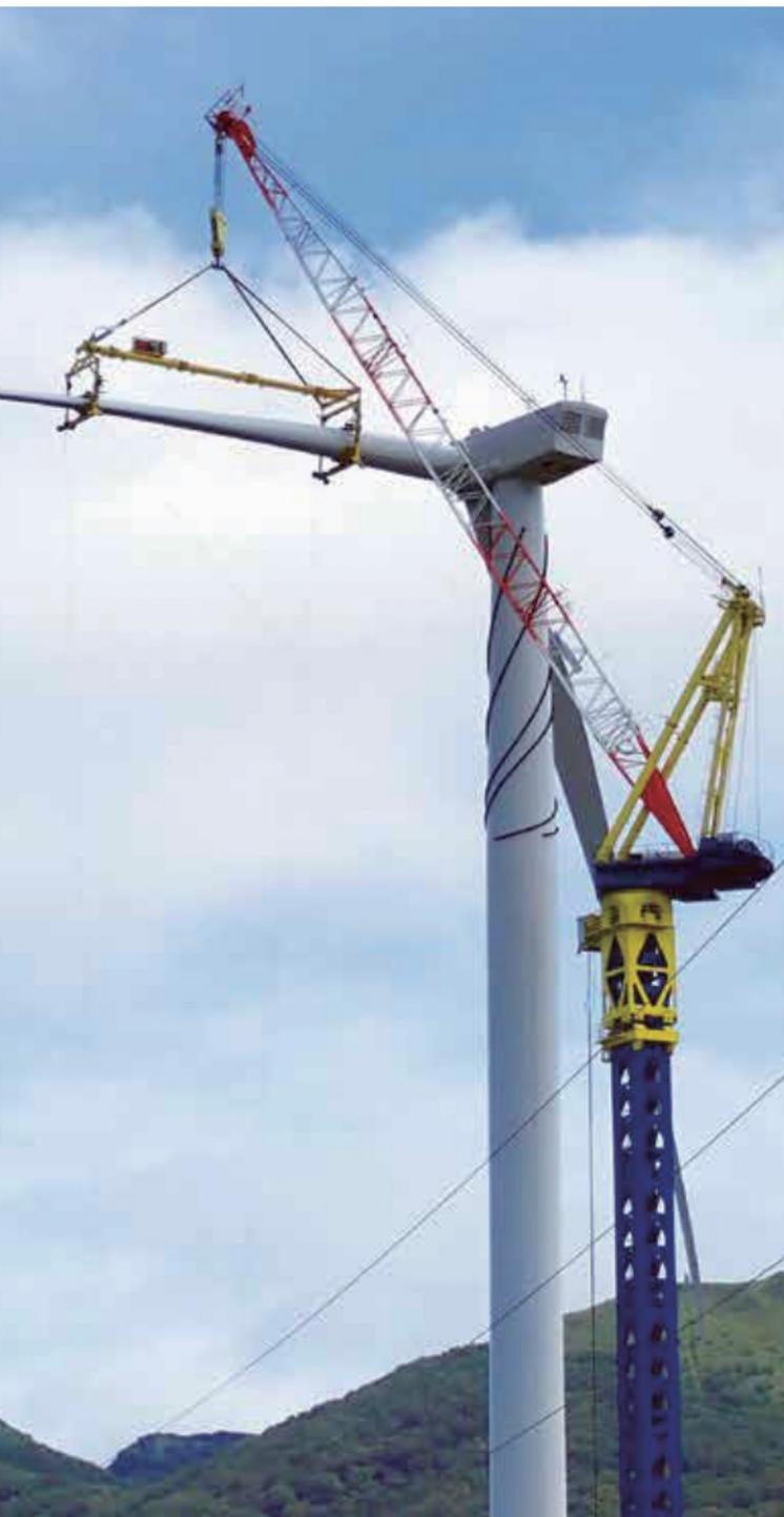
4MW級風車の据付け状況
