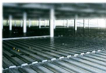
デッキプレート
