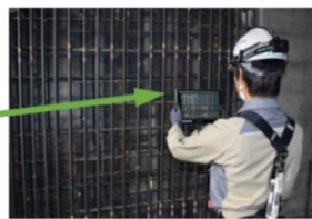
【デプスカメラ搭載タブレットでの計測作業】
