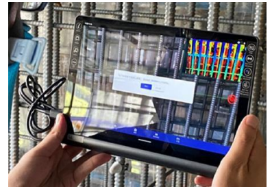
【デプスカメラ搭載タブレットでの計測作業】
