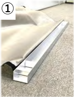
① シートの下部レールを床に設置する
