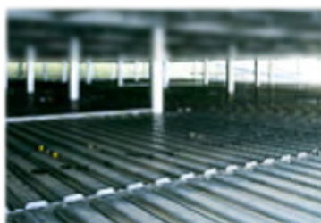
デッキプレート
