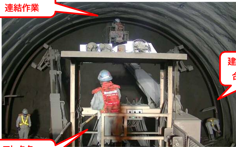
【写真 2】従来方式による支保工建て込み状況
