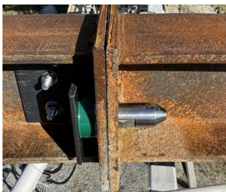
【写真 3】ワンタッチ式継手ボルト
