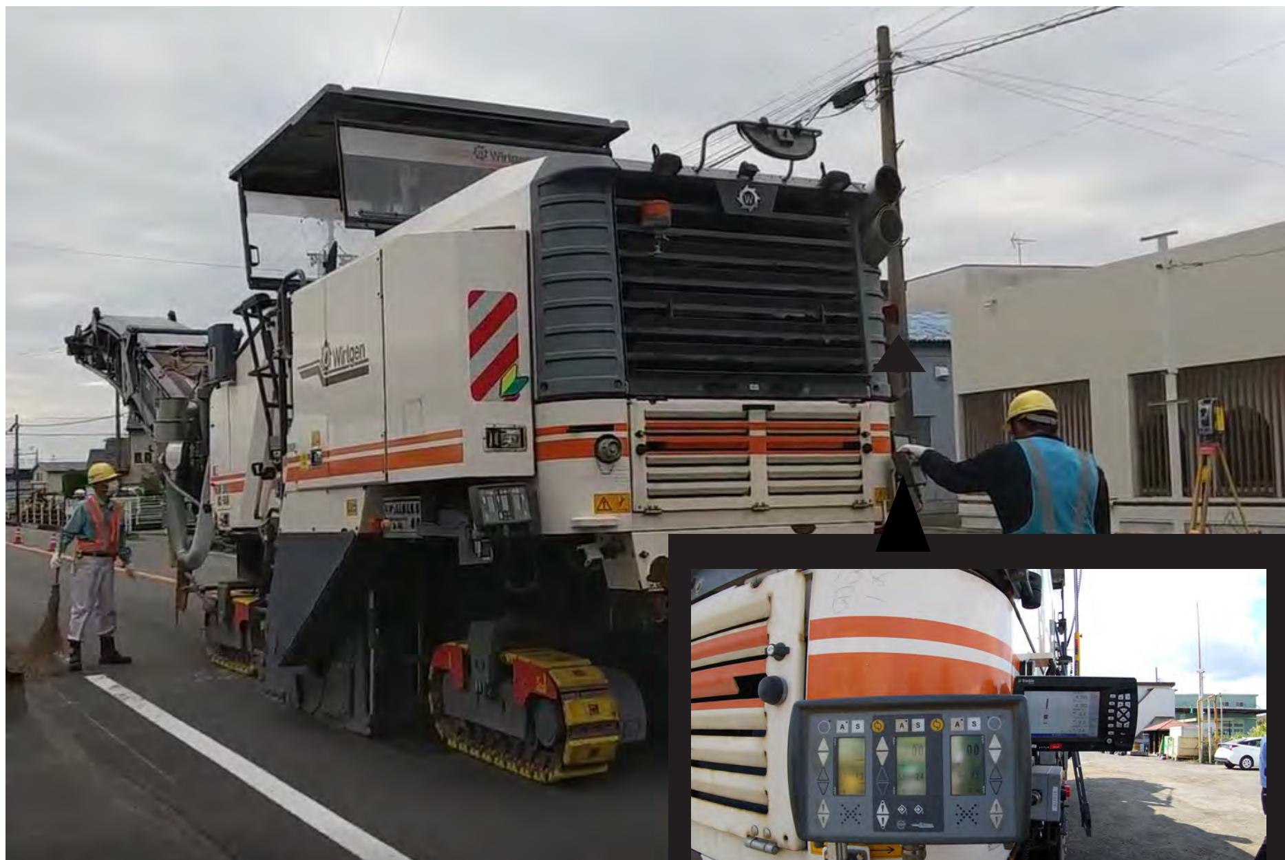
TSを用いた切削機マシンコントロールは切削深さを制御することで、オーバーカットを最小限に抑え、滑らかな表面を作成し、舗装プロセスでの追加の材料の必要性を最小に抑えます。多くの場合、切削機で一定の深さまで切削すると、舗装リフレッシュ工事の切削仕様を満たすことができますが、道路の平滑性向上についてはアスファルトフィニッシャーが担います。舗装制御システムは、深さと勾配を変えながら舗装することができるので、起伏のない滑らかな基盤面を作成できます。
