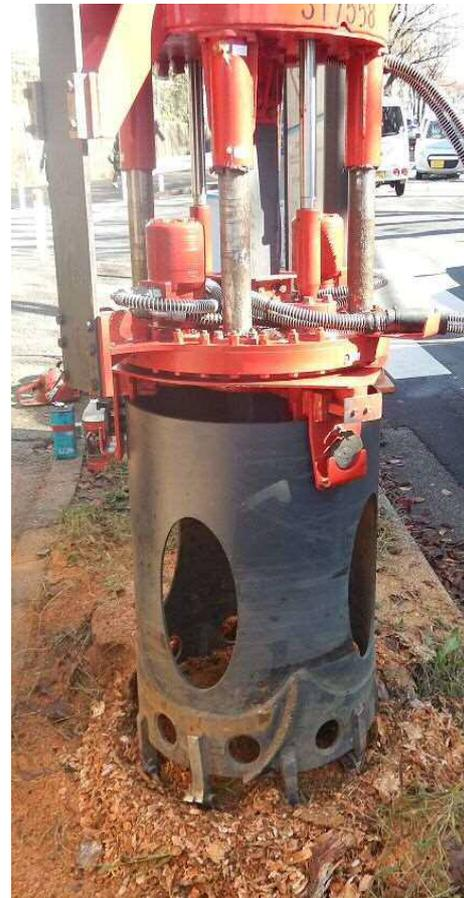
「根こそぎ切るソー」は、街路樹等の切株や切株周囲の根をバックホー※2に取り付けたホールソーで回転して切断、切り株の根が確実に切断(縁切り)された状態で掘り出されることで、樹木周囲の構造物等を破損することなく、切り株の根を取り出すことが可能になります。
