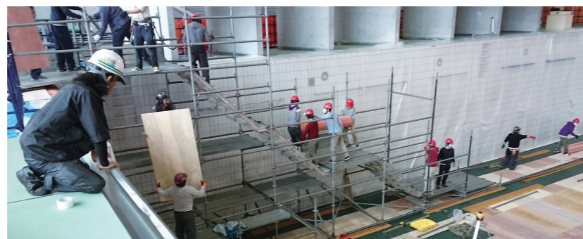
仮設スタンド組上げ準備風景
