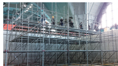
仮設スタンド組上げ作業風景
