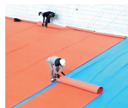
プール内のタイル養生作業風景
