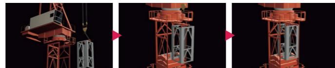
天秤を付けたタワーを吊り上げ待機させる タワー自重をタワー引込トロリに預ける 横行装置を操作しタワーを引き込む
