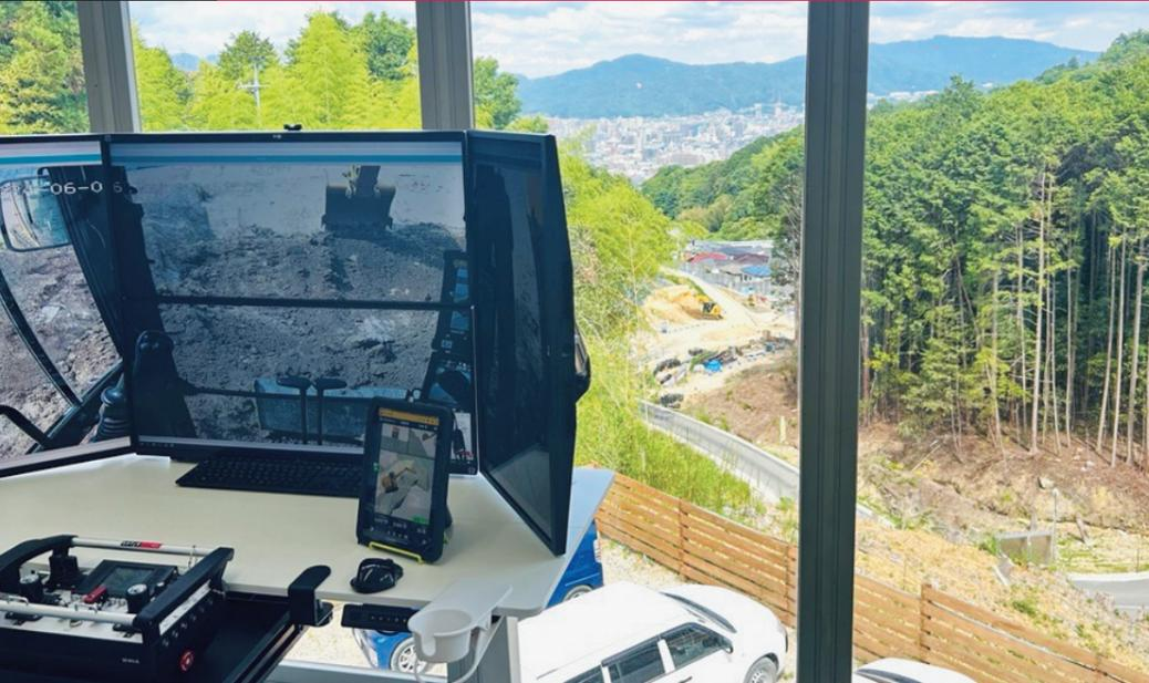
3階建ての仮設ハウスの最上階の一面をガラス張りにし、遠隔操作室として運用。お客様が現場内に構築したWi-Fiネットワーク経由で送られてくるカメラ映像と、操作室から重機を直接目視で確認できる2つの環境のもとで遠隔施工を実現した。
