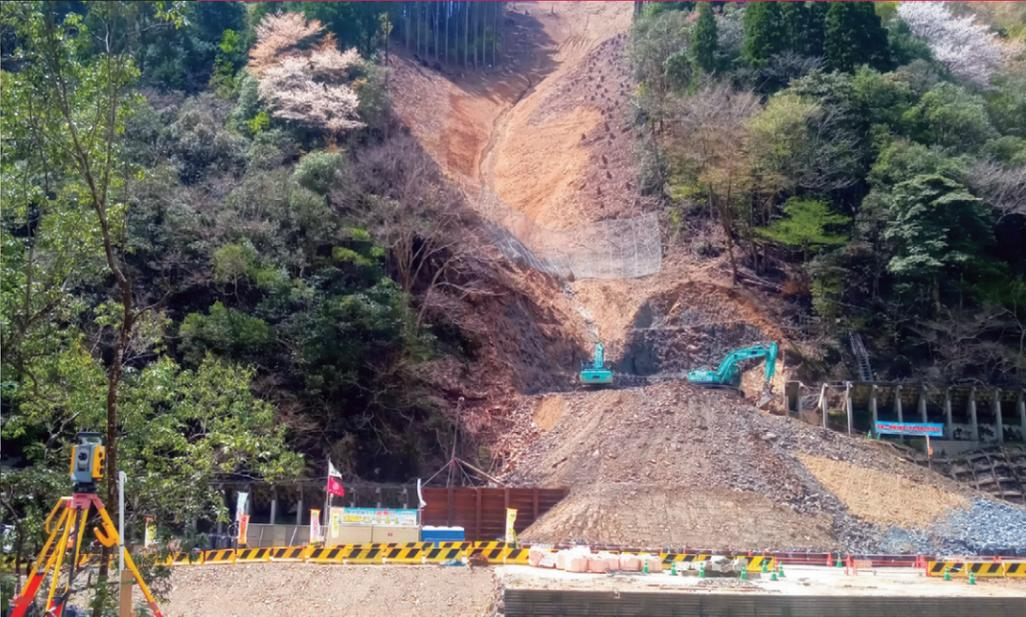
無人化施工のシステムは旭建設様とAKTIOが共同で構築。現場は山間のため衛星測位システムを使ったGNSSではなく、TS(トータルステーション)を使用。
