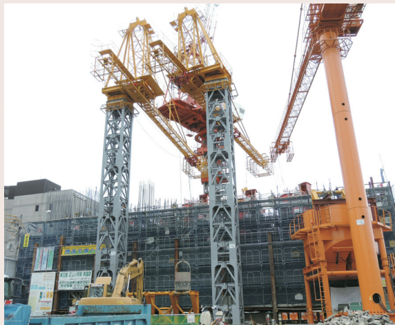
※左の2基が「アシンメトリー式排土クレーン」
