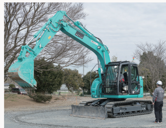
内部エリア、侵入時の様子
