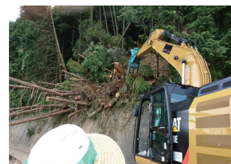
道路が寸断された被災現場にはショベルカー などで復旧作業に協力
