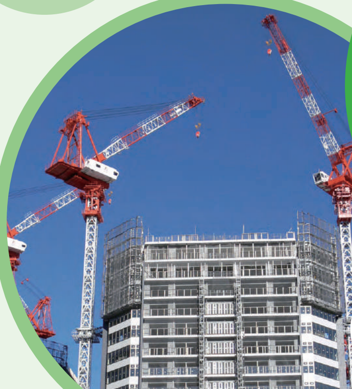
タワークレーン
