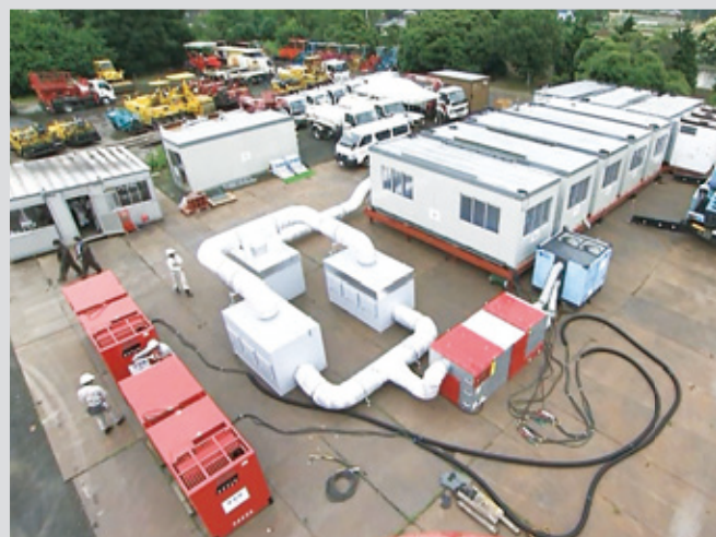
福島プロジェクトの施設・機械類
