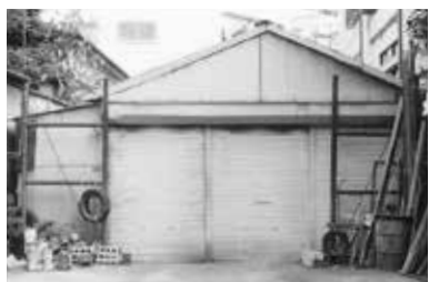
水中ポンプのレンタルを始めた深川工場(1968年)
