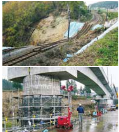
新潟県中越地震の震災復旧・復興にも協力(2004年)
