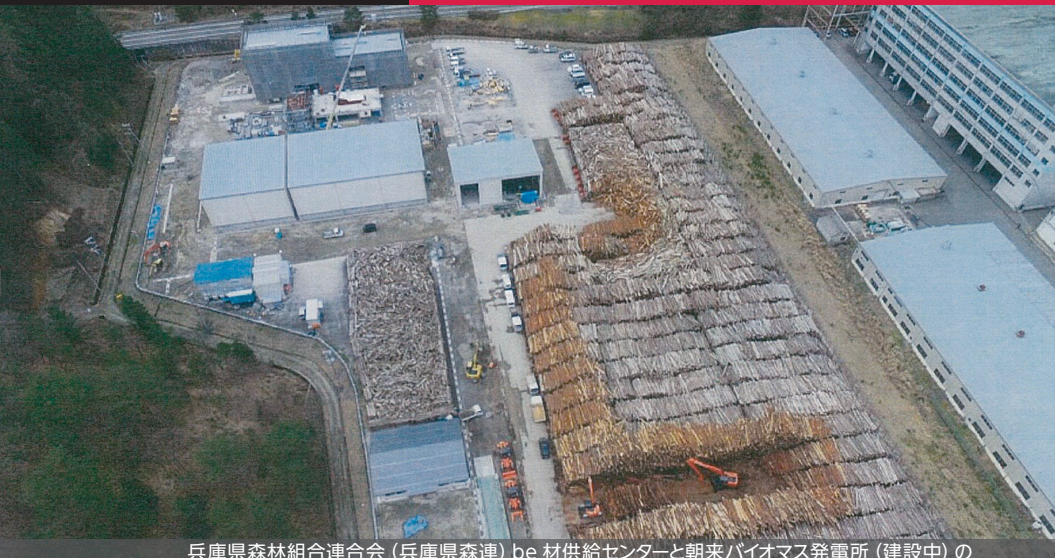
兵庫県森林組合連合会（兵庫県森連）be 材供給センターと朝来バイオマス発電所（建設中）の敷地全体写真（昨年 12 月より発電所稼働スタート）
