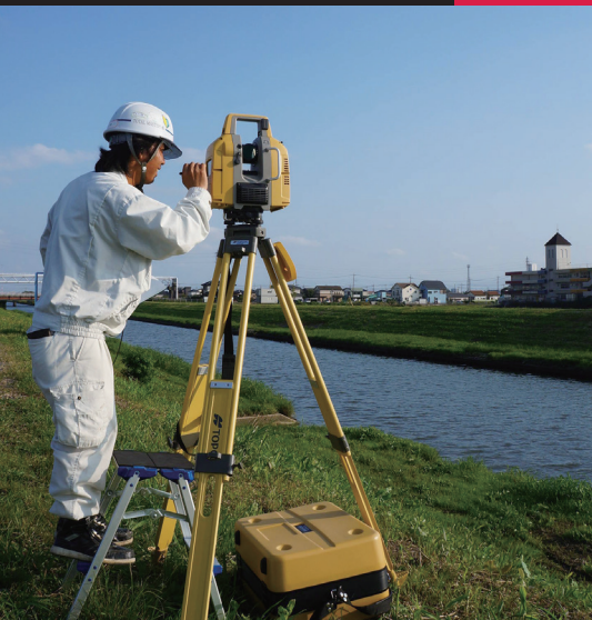
LSによる三次元起工測量の様子
